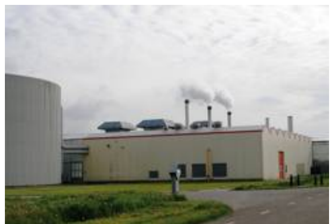
Serra olandese riscaldata tramite un impianto di cogenerazione. Invece che in una caldaia, il metano viene bruciato in un motore endotermico accoppiato: a un alternatore, per produrre energia elettrica venduta in rete; a un sistema di recupero del calore, usato per scaldare la serra, e a un catalizzatore a urea che recupera anche la CO 2 . A sinistra l'imponente buffer per l'accumulo dell'energia termica.
