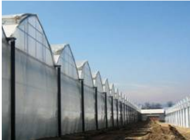
Serra tecnologica in Russia coperta in doppio film gonfiato, con finestre di colmo ad ala di gabbiano e riscaldamento a metano. L'investimento nell'impiantistica è molto elevato, ma consente cicli di 12 mesi e una fornitura continua alla gdo.
