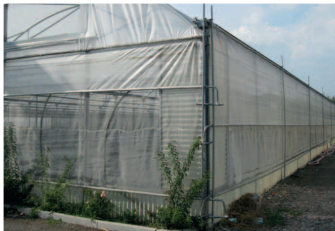
Le serre di Albano, protette da reti antiafidi, presentano aperture variabili e fisse in grado di consentire un'ottima ventilazione.
