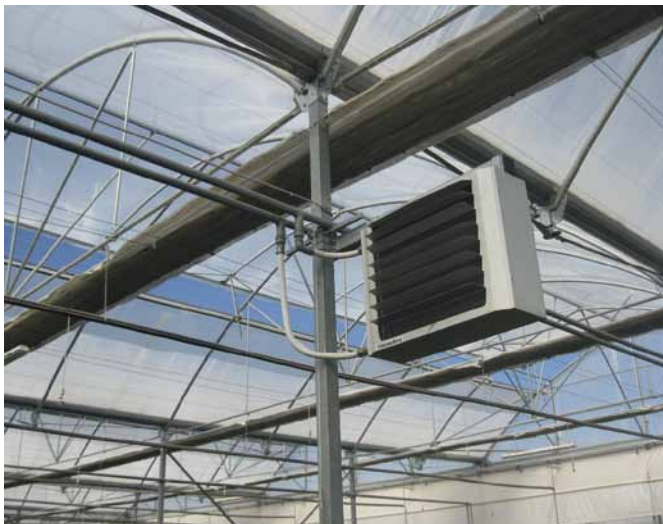
La poinsettia ha bisogno di una temperatura compresa fra 16 e 22 °C. Nella foto termoventilatore per il riscaldamento.
