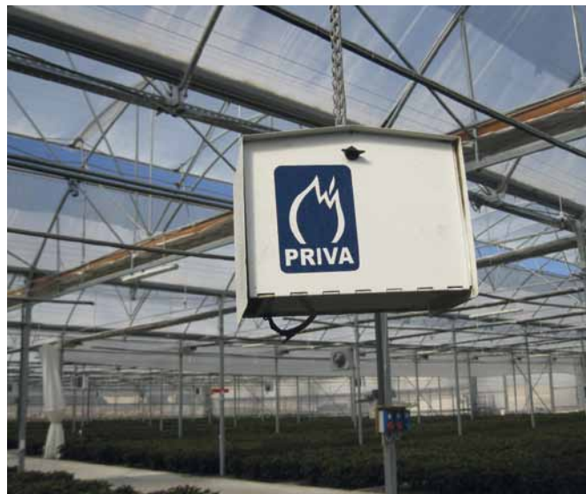
All'interno di ogni serra temperatura e umidità vengono gestite da una sonda climatica computerizzata.
