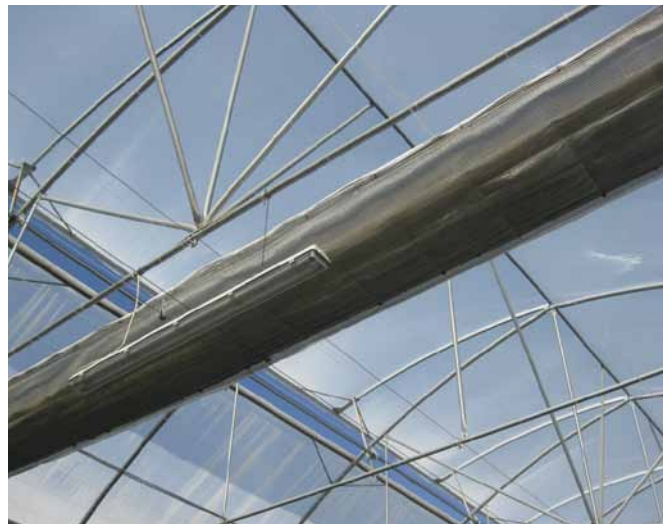
I teli schermanti o ombreggianti vengono aperti durante l'inverno per evitare che l'aria calda si disperda nella parte superiore della serra.
