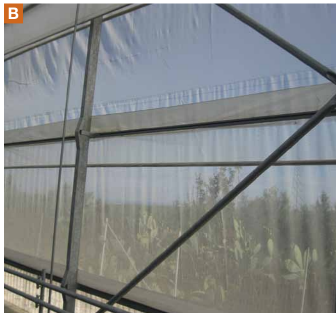
A Per garantire in serra il clima adeguato Auricchio ventila il più possibile, attraverso le aperture al colmo (A) e le finestre laterali con doppia apertura, sopra e sotto (B).
