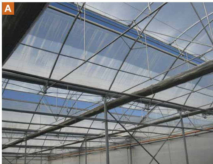
A Per garantire in serra il clima adeguato Auricchio ventila il più possibile, attraverso le aperture al colmo (A) e le finestre laterali con doppia apertura, sopra e sotto (B).
