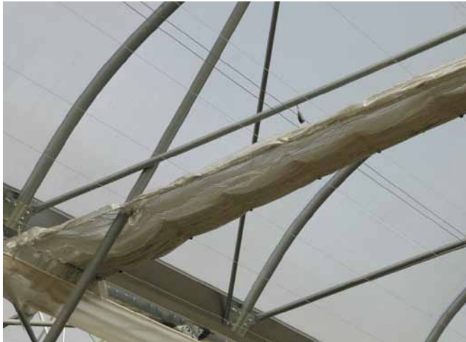
Teli ombreggianti rivestiti in alluminio riducono l'irraggiamento nei giorni più caldi e contribuiscono a limitare l'ingresso di aria fredda nei mesi invernali.
