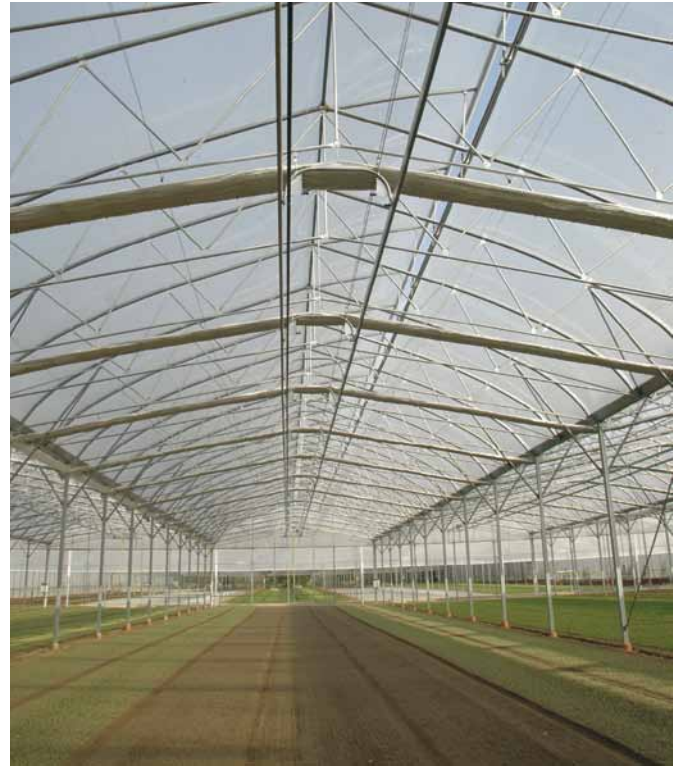
Il doppio telo di copertura assicura tre gradi di temperatura in più rispetto all'esterno durante la stagione fredda.
