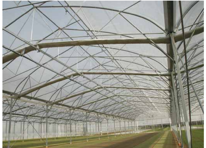
I nuovi teli adottati dalla famiglia Gambaro possiedono una faccia rivestita con lamelle di alluminio, per aumentare l'effetto di rifrazione della luce solare.
