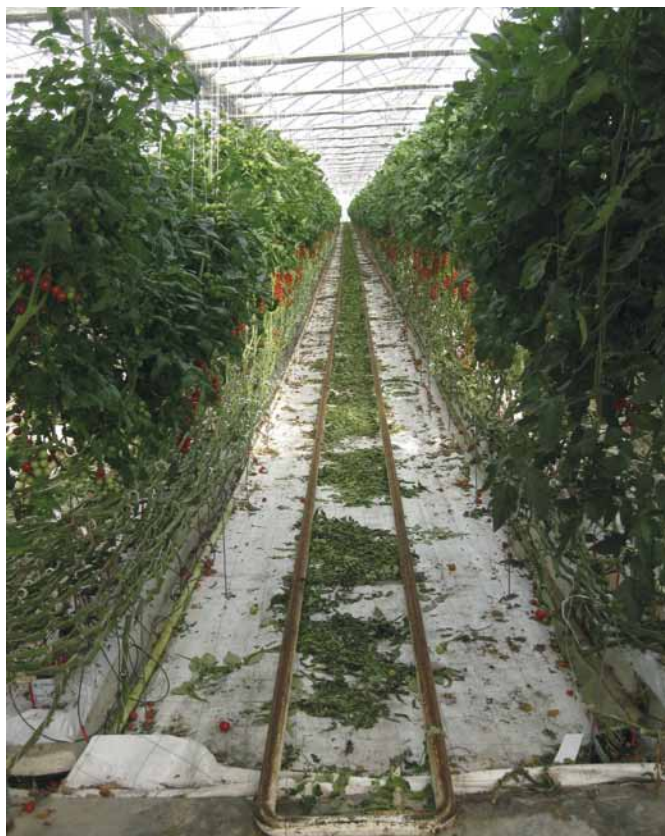
Per mantenere una temperatura interna di almeno 18°C è stato realizzato un impianto di riscaldamento costituito da un circuito chiuso di 40 km di tubi, formato da doppi binari fra ogni due file di piante.
